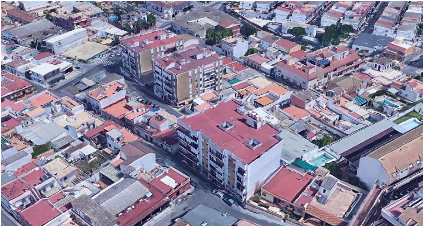
Tipología residencial plurifamiliar entorno calle San Gines
