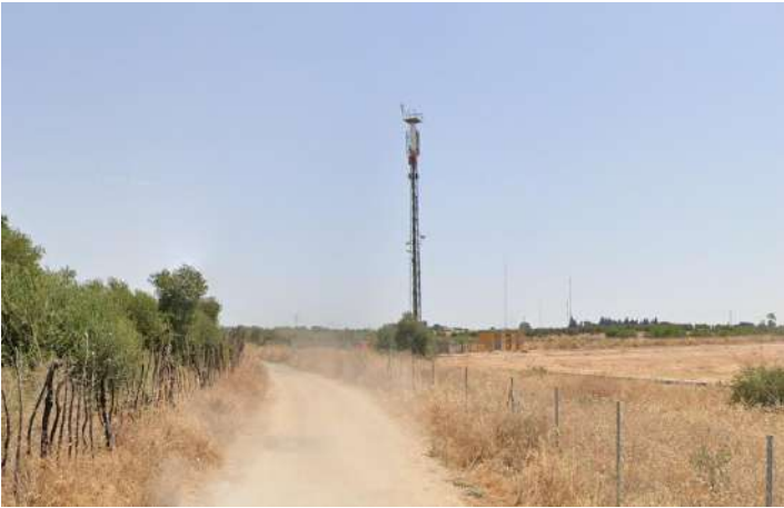
Torre al norte. Fuente: Google Earth
