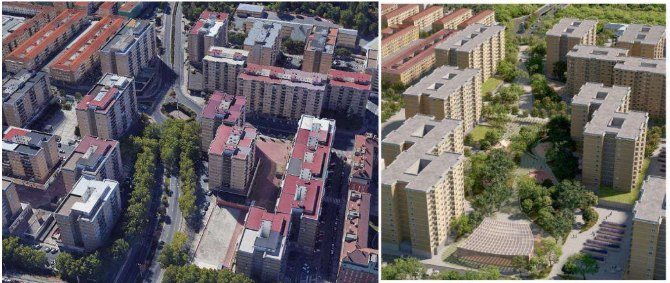
Ejemplo actuación de soterramiento. San Jorge, Pamplona. Fuente: www.diariodenavarra.es
