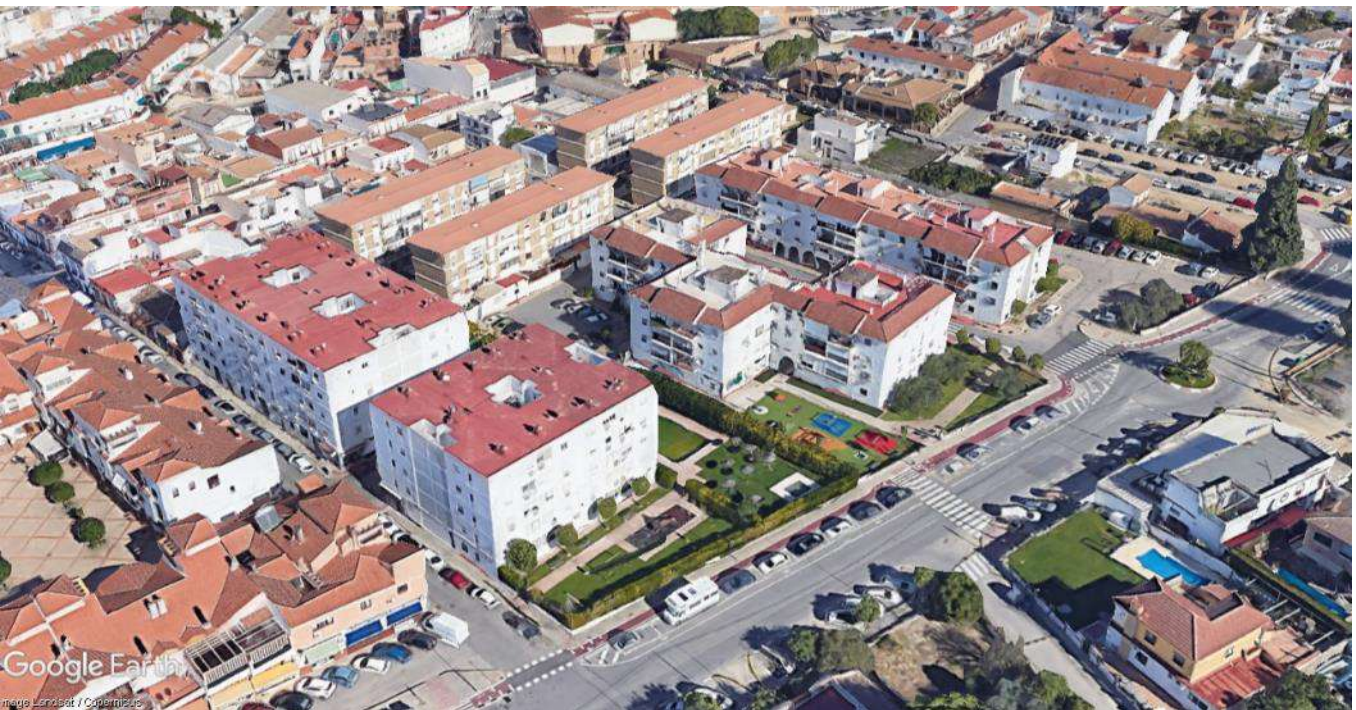
Tipología residencial plurifamiliar entorno calle José Luis Caro
