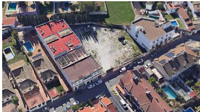
Aparcamiento la Calle Sevilla Fuente Google Earth
